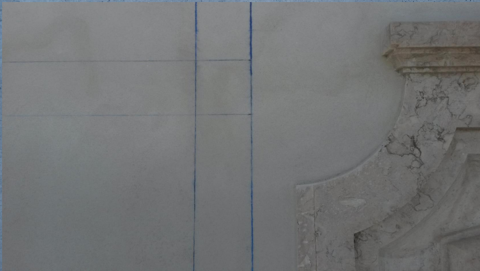
Marcações e moldes para execução dos relevos em argamassa
